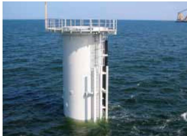
デンマークの大陸棚に建設されている風力発電設備に使用されている35mのバイル80本に塗装された実例。塗料40,000ℓ以上を使用。
