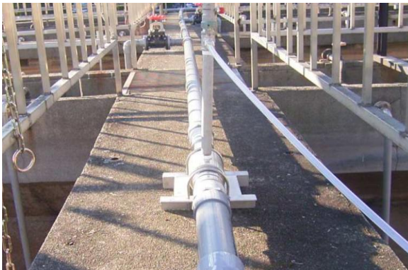
水中ポンプから陸上設置されたオゾンマイクロバブルYJ装置
