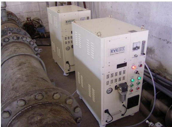
現場に設置された YJ ノズル専用 EVO3G オゾナイザ
